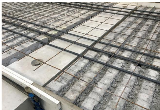
Fig. 1: O sistema Grooved Hollowcore antes da colocação da camada superior de concreto. Detalhes importantes: são colocadas barras de armadura diretamente nas lajes e separadas de modo adequado do apoio, para que o concreto preencha a fenda restante e o torque de flexão possa ser transferido; eventualmente são necessárias tampas, para que os espaços ociosos das lajes alveolares protendidas não fiquem inundados com concreto.
